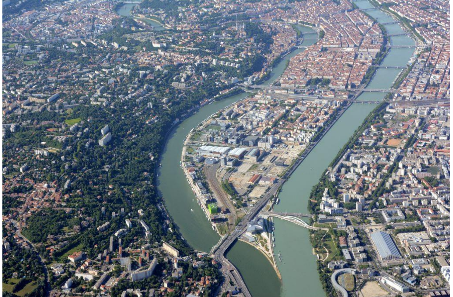
La Confluence, avec la phase 2 de la réhabilitation en cours
